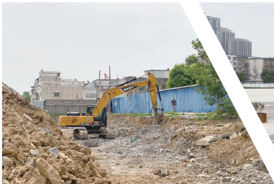
建设中的滨河南路大庆路东生态停车场
